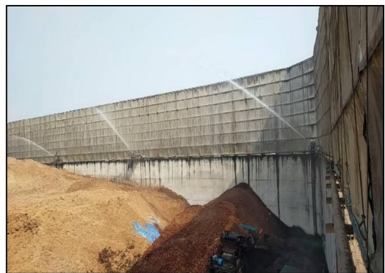
รูปที่ 8 ระบบหัวพ่นน้ำ (Sprinkler) รอบกองขานอ้อย
