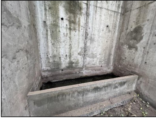
รูปที่ 9 รางระบายน้ำล้นรอบลานกองเก็บขานอ้อย
