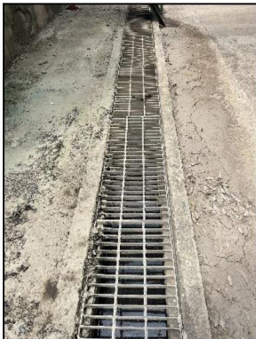
รูปที่ 15 รางระบายน้ำฝนไม่ปนเปื้อน
