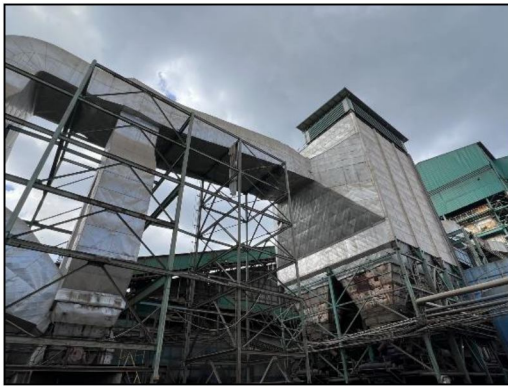
รูปที่ 1 ระบบดักฝุ่นแบบไฟฟ้าสถิต (ESP)
